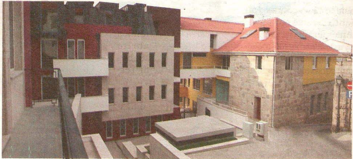
➔ O edifício situa-se no centro histórico de Viseu
