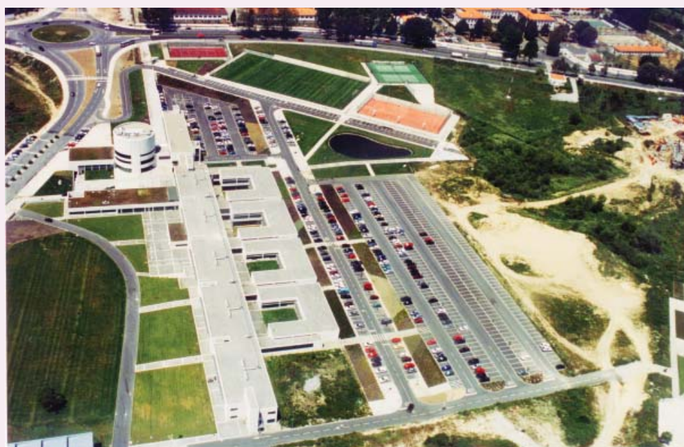
Uma obra com planeamento e fiscalização Planivis
