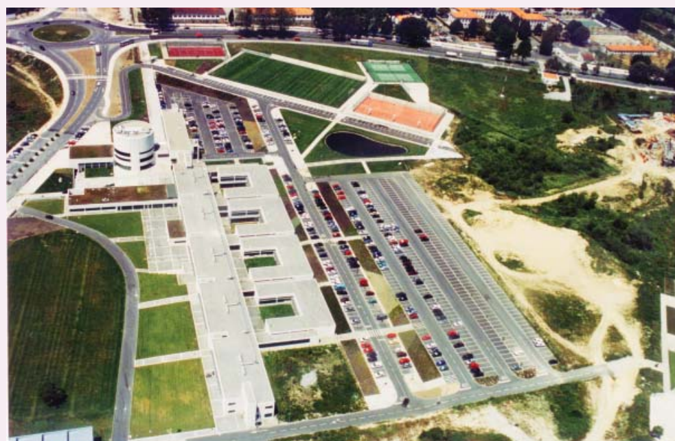
Uma obra com planeamento e fiscalização Planivis
